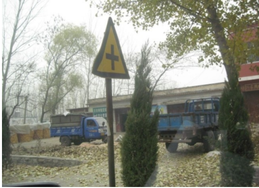
标志版面损坏
