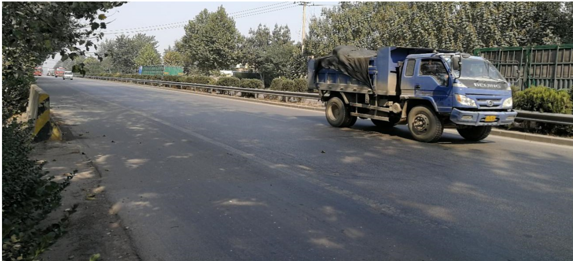
低填浅挖路段现状
