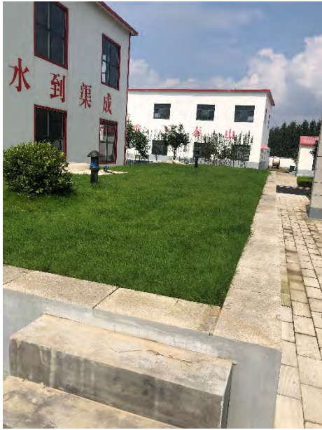
原水池+浓水池
