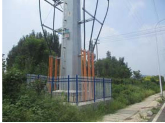
图6-1（2） 塔基下电缆上方周围恢复情况
