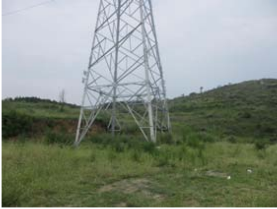
图6-1（1） 塔基周围恢复情况
