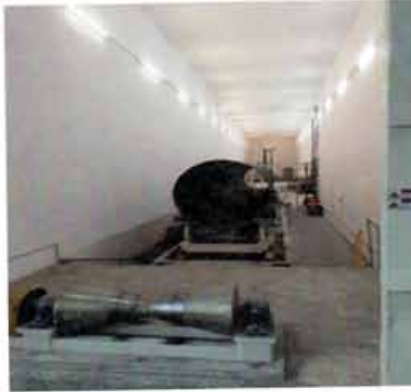
图 2 项目现场照片
