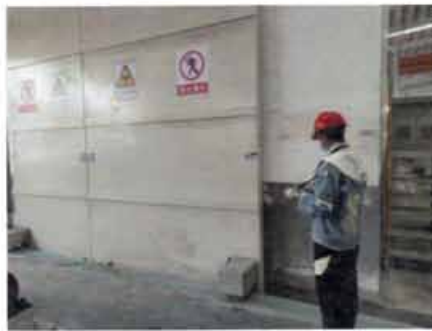
图 3 现场检测照片
