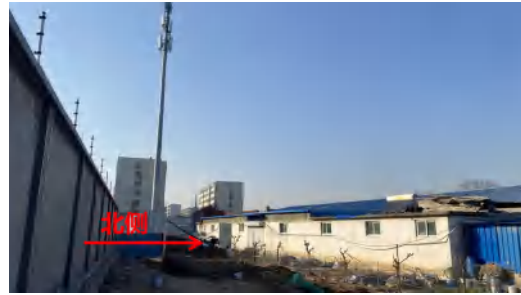
图 4-6 天德 110kV 变电站北侧
