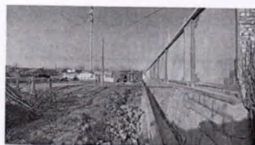
图 1-3 天德 110kV 变电站西侧
