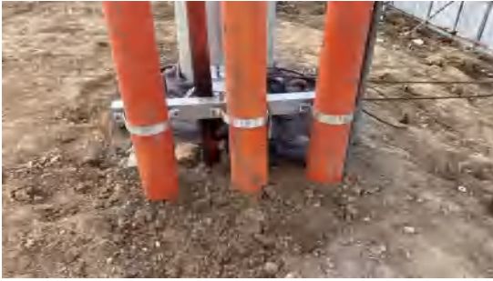
图6-9 塔基处土地平整
