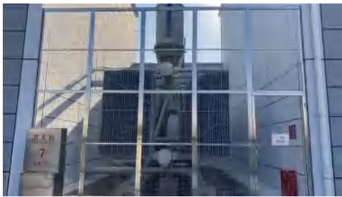
图6-11 1#主变散热器
