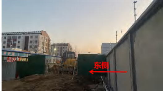
图 4-3 天德 110kV 变电站东侧
