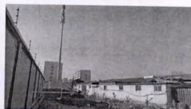
图 1-4 天德 110kV 变电站北侧
