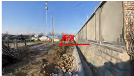
图 4-5 天德 110kV 变电站西侧
