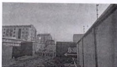
图 1-1 天德 110kV 变电站东侧
