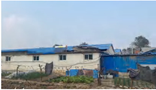
图 2-1 变电站西北侧 12m 民房
