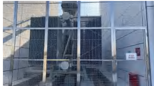
图6-12 2#主变散热器
