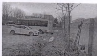
图 1-2 天德 110kV 变电站南侧
