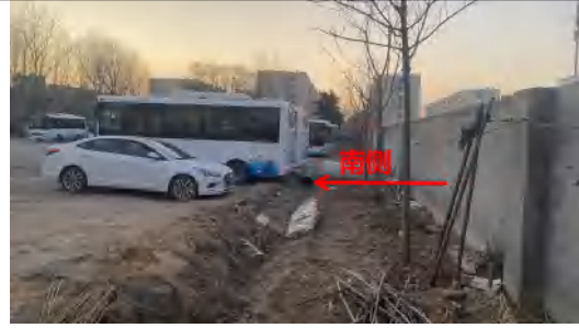
图 4-4 天德 110kV 变电站南侧
